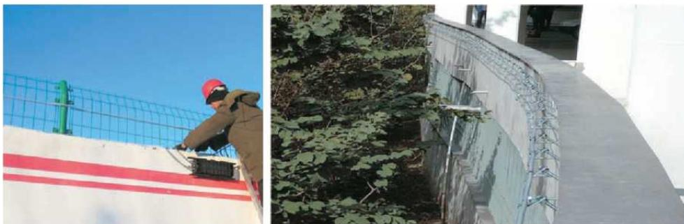
Основная используемая зона системы охраны периметров - стены и ограждения вокруг кампуса, предотвращает перелезание через стену и вторжение в кампус посторонних людей. Система FPMS установлена для мониторинга двумя способами прокладки: по периметру ограждения и подземная прокладка у главных ворот. Эффективное применение системы успешно разрешило вопросы безопасности по периметру кампуса.
